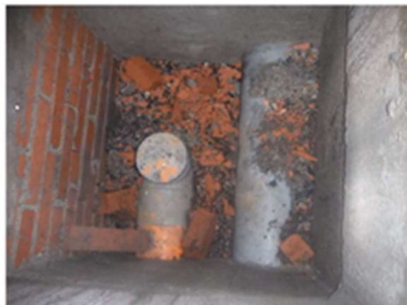
Foto 2 - Pozzetto duale senza possibilità di travaso
