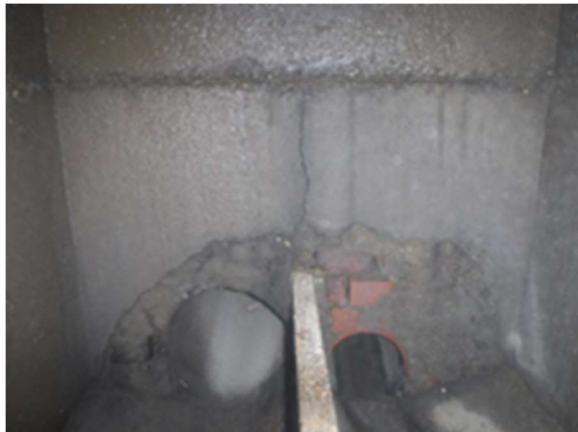
Foto 1 – Pozzetto duale con possibilità di travaso
